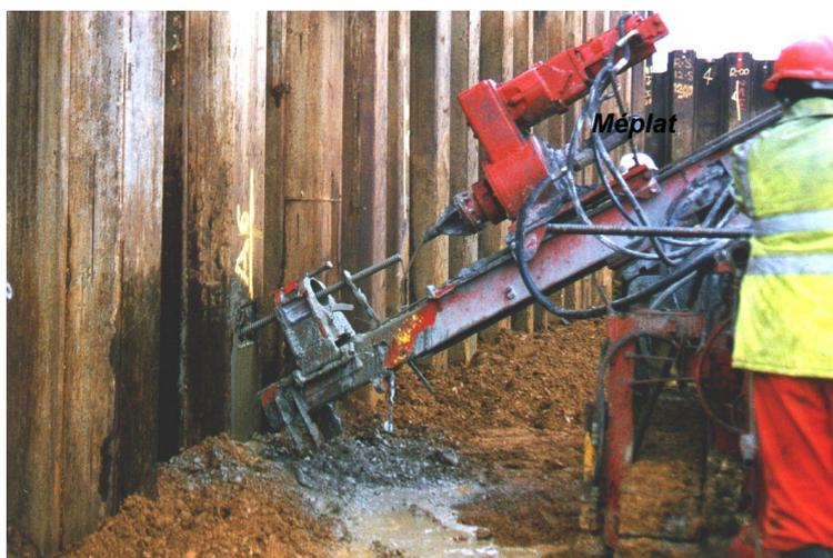
La boîte d'injection doit être solidarisée de la machine par une attache solide avec le chariot de la foreuse.
